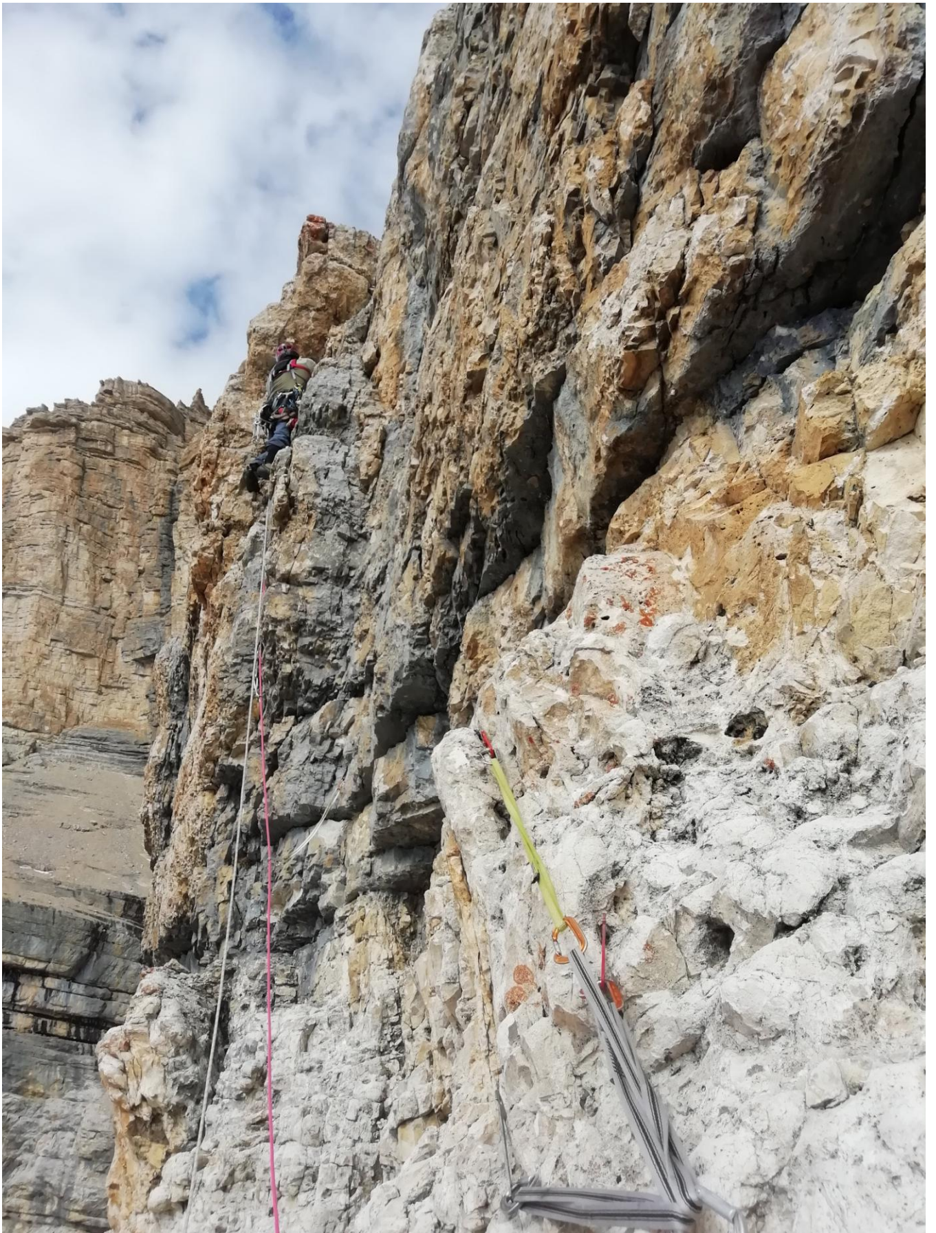
Рис.29. Вид со станции R14 на начало участка R14 - R15.
