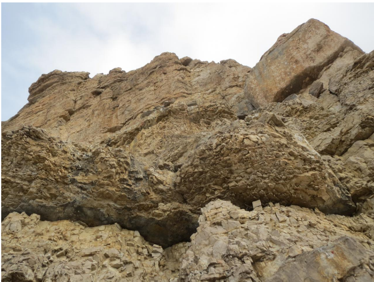
Рис.37. Вид со станции R21 на участок R21 - R22.
